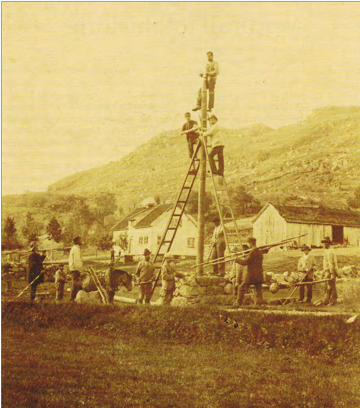
Telegraflinjen mellom Flekkefjord og Egersund bygges forbi Hetland i Heskestad i 1857. Det kreves bare en tråd å sende morsesignaler, den festes i toppen av stolpen.
